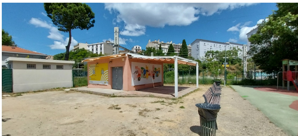
Figure 4 : Local bâti - 34m 2
